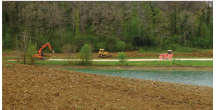
Photo 21 : Aménagement d'un chemin routier au lac du Bousquetara
